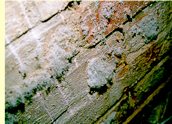
Innenwandbereich einer Außenwand eines Archivs
